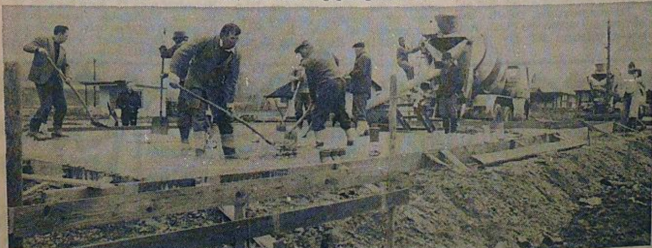
Mitglieder der Alfelder Kleingartenkolonie Perk gossen die Betonplatte für das neue Gemeinschaftshaus
